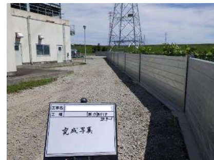
止水壁の設置
