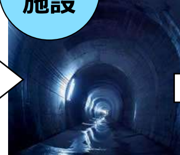
【導水トンネル】
