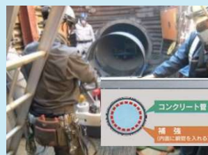
例：管路の耐震補強
