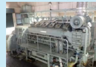
例：自家用発電機の整備
