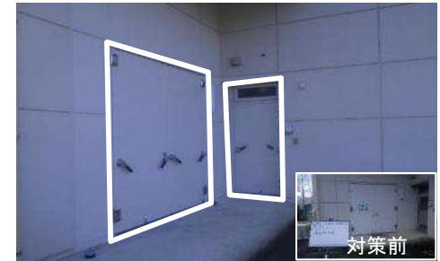
耐水扉の設置
